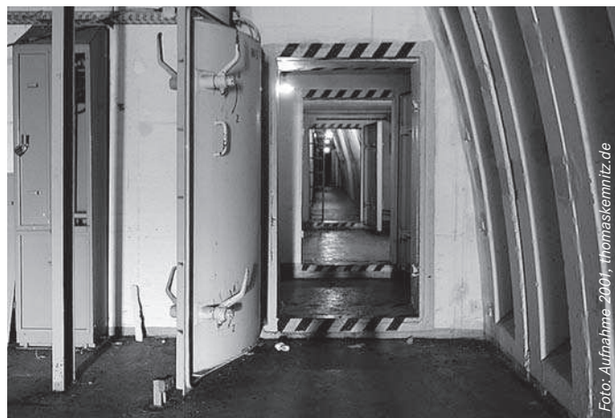
Im Inneren der Nachrichtenzentrale der ehemaligen NVA-Bunkeranlage, Foto von 2001
